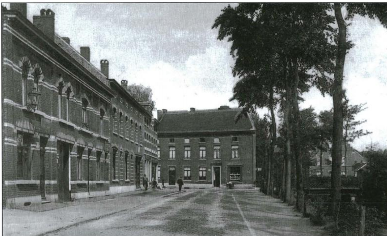
Zicht vanuit de Dworpstraat op de Zennebrug en de Molenstraat.
